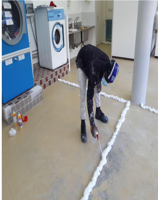
Traitement des fissures
