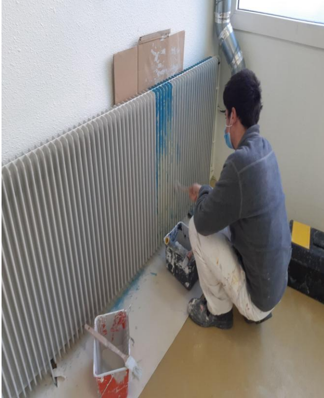
Rafraichissement d'un radiateur
